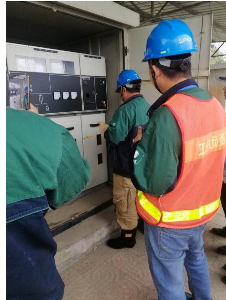
园区电气设备运行已在 10 年以上，GGD 型配电柜及各种电气原件老化急需更新。每年夏季用电高峰老化的电气设备线路经受着突然“放炮”烧毁的考验；为避免此类故障发生，保障园区电气设备安全运行，为入住园区企业及公司内部提供安全可靠的用电环境，我们每年对园区电气设备进行一次彻彻底底的检修检测工作。掌握电气设备现状，对存在的问题进行解决，为电气设备安全运行夯实基础。
